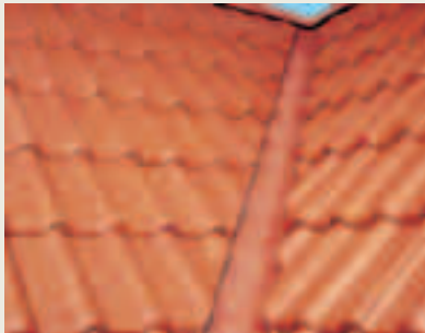
АЛУМИНИЕВА УЛАМА Висококачествена двустранно приложима улама. Чрез предварително изработените профилни линии е възможно директно огъване и оформяне върху покрива. Монтира се със скоби към летвата за керемиди.
