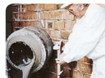
**3** При неравномерно попиващи основи предварително напръскайте с рядък цименто-пясъчен разтвор. При равномерно попиващи основи предварително измажете на тънък пласт с по-рядък разтвор на хастарната мазилка **201P**, като запълвате фугите между тухлите.
