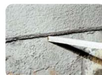
**6** В зависимост от крайното покритие - **weber.min** или **weber.pas** тънкослойни мазилки, повърхността на хастарната мазилка се изпердашва до получаване на подходяща гладкост.
