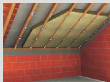
2. Да се монтират носещи подконструкции от гипскартонени плоскости, съгласно упътване от производителя. Частично залепете по дължината на подконструкцията външтуно залепваща лента
