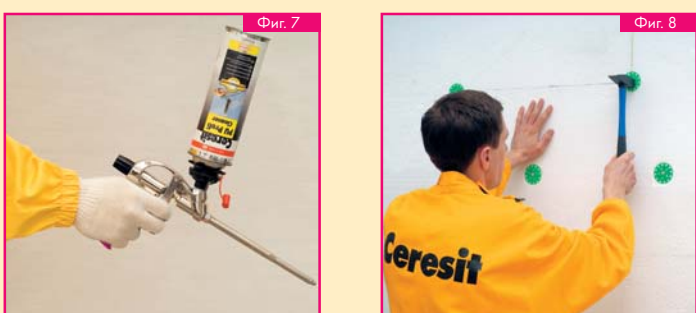
Пистолетът трябва да се почисти с чистител за пяна (например MAKROFLEX CLEANER) не по-късно от 30 мин. след приключване на работата, за да се предотврати запушването му с изсъхнала пяна. За почистване на вътрешността на пистолета, флаконът на чистителя се завива към него и се пръска няколко пъти.
