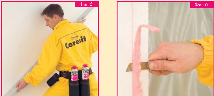
Подравняването на фиксираните плоскости се извършва в рамките на 20 мин. след полагането, с помощта на мостор или дълга летва.
