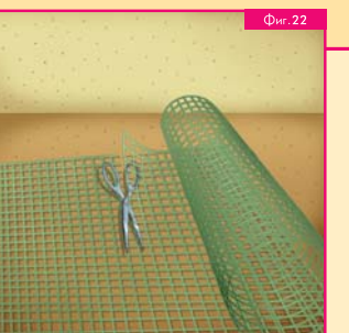
От ролката на мрежата се отрязват ивици съответната дължина и се заглават.
