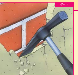
Освен отстраняване на некачествената мазилка, издаваща "кух" звук, се препоръчва да се свалят мазилката около странциите на врати и прозорци, за да се положи и там полистирен с дебелина минимум 2-3 cm и да не се покриват изцяло рамките. Ако на тези места не се положи полистирен, се получава изтичане, в следствие на което се появява влага около вътрешната рамка на страницата.
