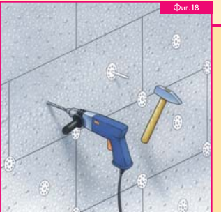
Ако основата е с недостатъчна носеща способност, плоскостите от експандиран полистирен Ceresit CT 315 трябва да се укрепят допълнително с дюбели с лепенка, ако полистиренът е бил изложен на въздействието на слънцето по-дълго от две седмици и е пожълтял.
