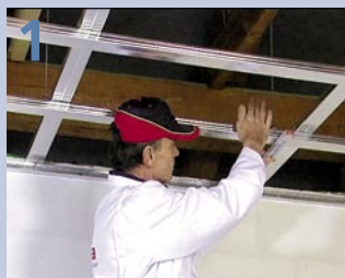
полага се металната конструкция
