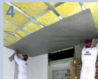
полага се защитното фолио – пароизолация
