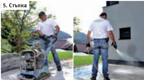
Виброуплътняване с фугиращ пясък / поливане с вода
