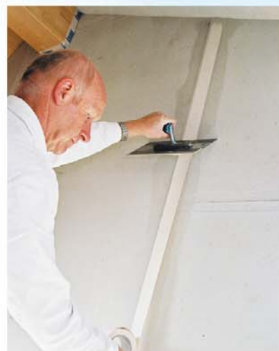
Полага се хартиена лента за покриване на фуги.
