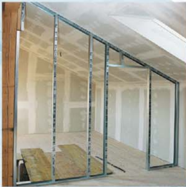
Металната конструкция на Кнауф преградна (щендерна) стена
