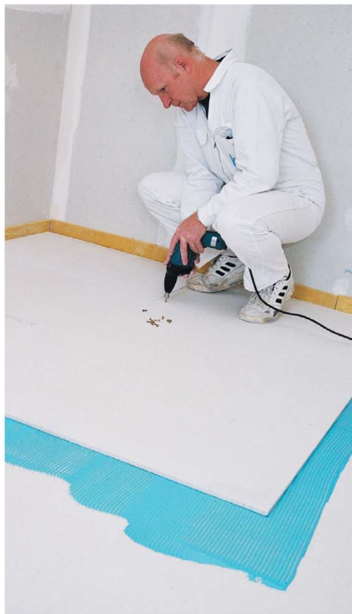
Двата слоя Vidifloor плоскости на Кнауф се слепват и свързват с винтове или кламери.
