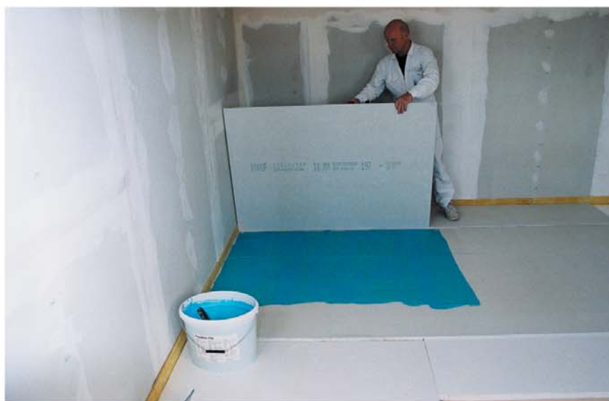
След нанасянето на Кнауф Aqualine лепило за сух под се полага вторият слой плоскости с изместване на фугите.
