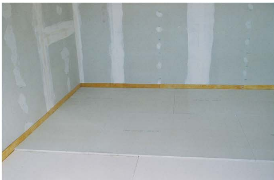
Vidifloor плоскости на Кнауф, положени върху пенополистирол.
