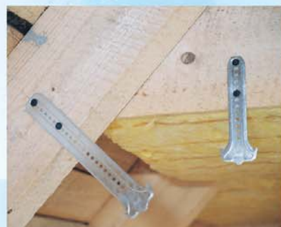
Закрепване на носеща конструкция с Кнауф анкерен окачвач 170 mm, респ. 270 mm
