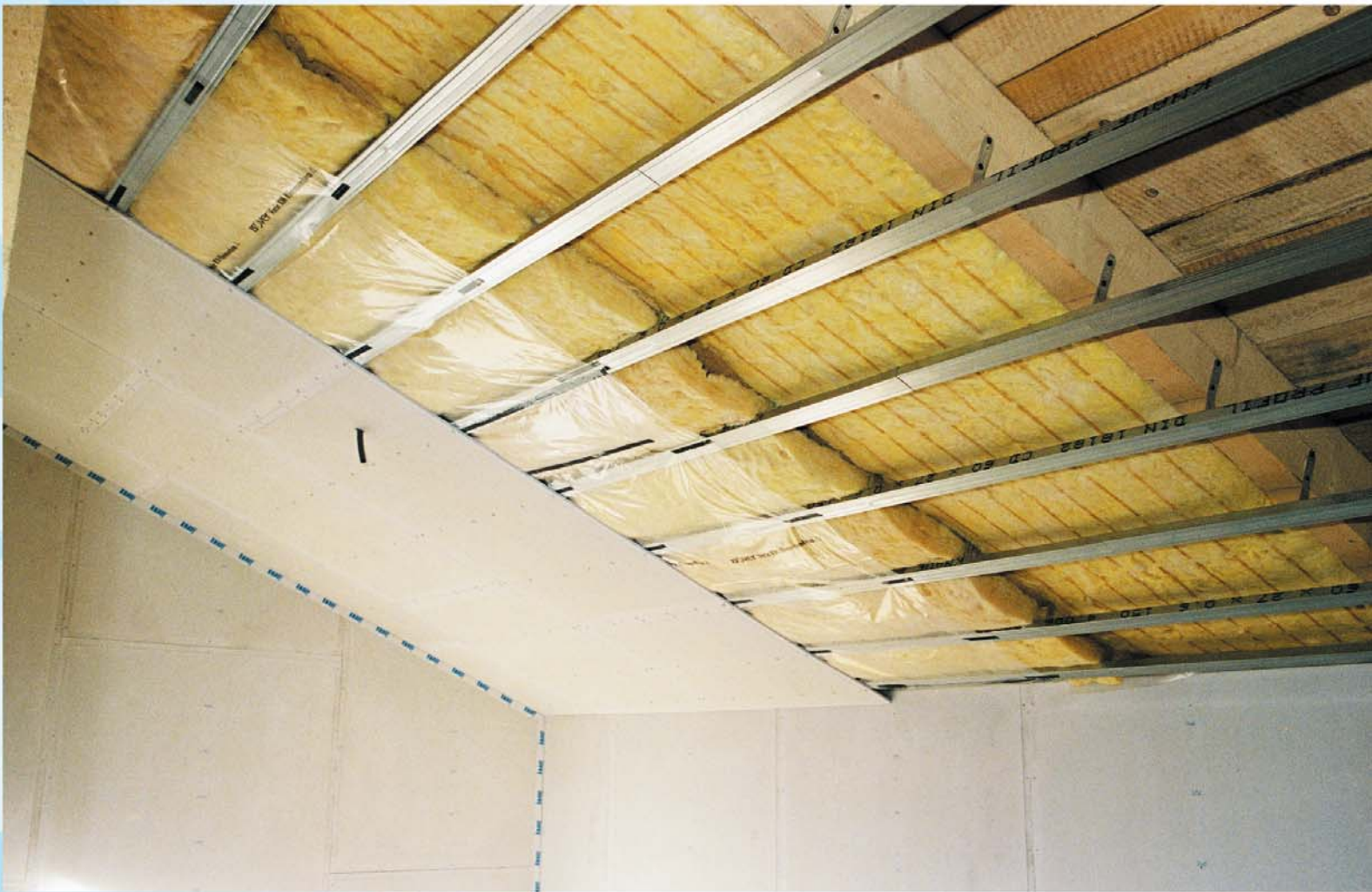
Правилно изграждане на облицовката на тавански етаж с Vidiwall гипсфазерни плоскости с VT кант
