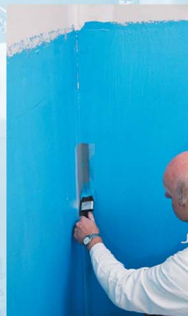
Полагане на уплътнителна лента Кнауф в ъглите.
