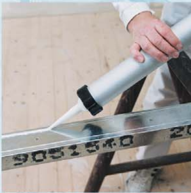
Нанасяне на Кнауф кит върху UW профила (при изисквания за шумоизолация)
