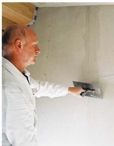
VT кантът се запълва с Vidiwall-Filler или Uniflott.
