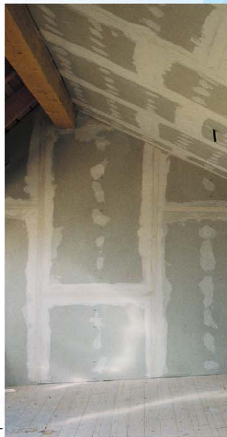
Техника на фугиране при VT кант
